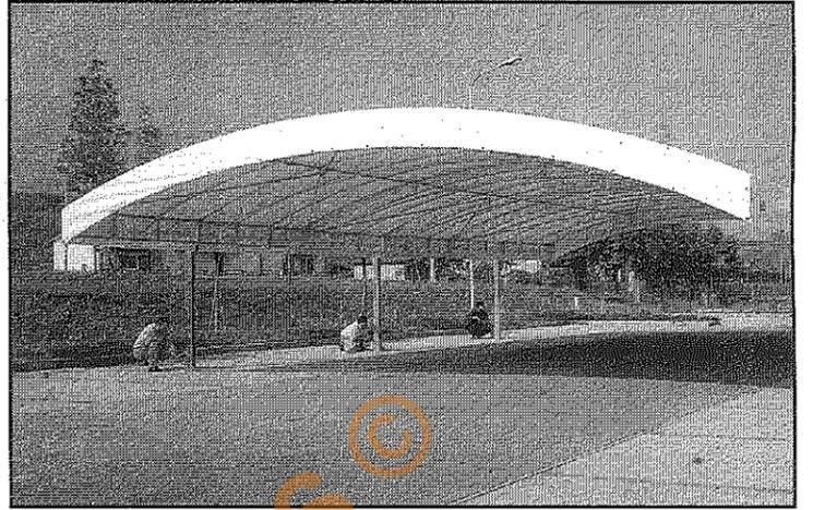
ovest, dove sarà ricavato anche un utile deposito coperto di circa mq. 70. La struttura sarà composta da capriate metalliche zincate di mt. 16 di larghezza con sovrastante telo a copertura, poggiante su n. 8 pilastri di sostegno in ferro; l'altezza massima della struttura sarà di mt. 5,30.
